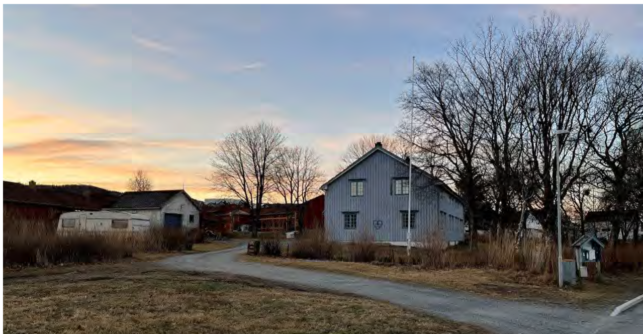
Figur 22 - Presteboligen sett fra øst.
