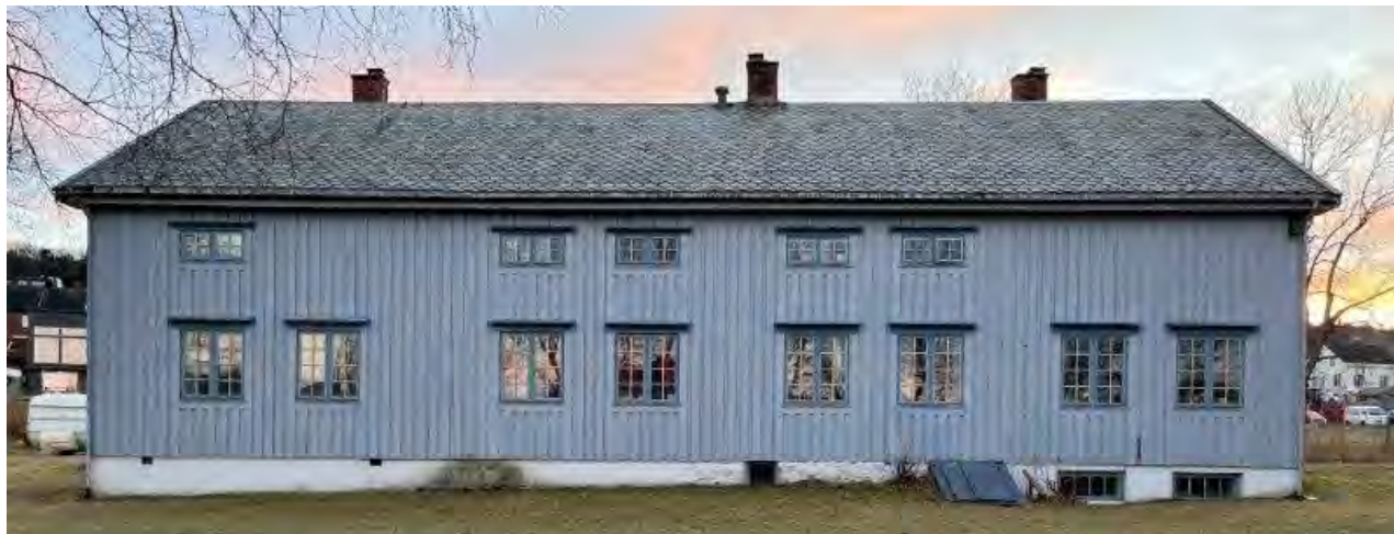
Figur 36 - Fasade mot nord.
