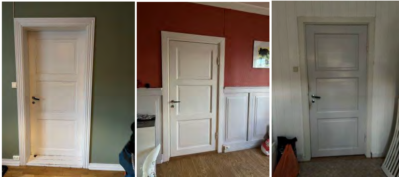
Figur 42 - Dører i 1. etasje.
