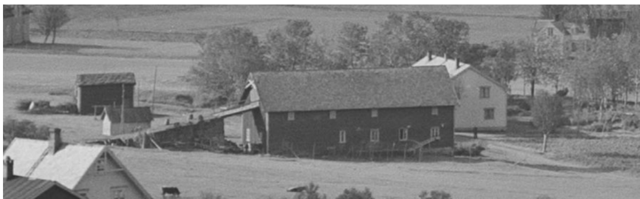
Figur 19 – Taket på presteboligen ble løftet under 2. verdenskrig, slik at det ble to fulle etasjer og et loft. Foto: Mittet 1948, Karl J. Holst, Nasjonalbiblioteket (Public Domain).
