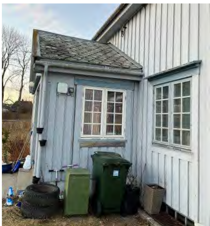
Figur 31 - Inngangsparti på sør-fasaden desember 2021.
