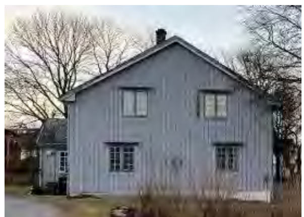
Figur 34 - Fasade mot øst i desember
