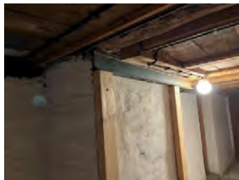
Figur 68 - Gang i kjelleren.
